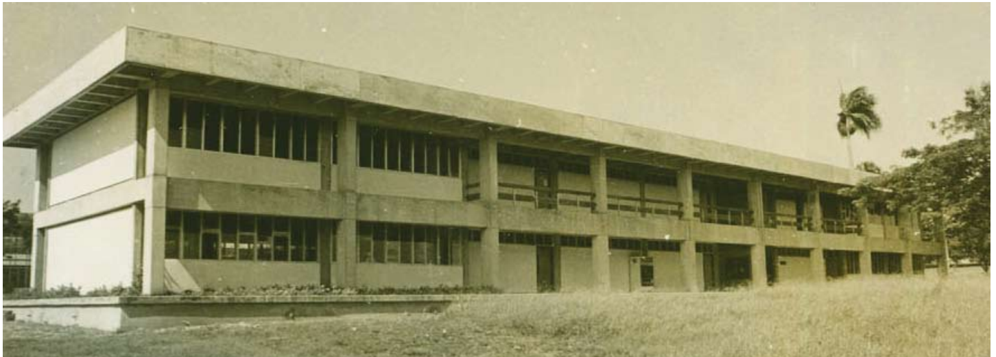
Uno de los primeros edificios de aulas en el campus de Santiago
